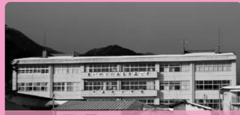
建て替え工事中の2年間暫定的に片品小学校となる北小学校
