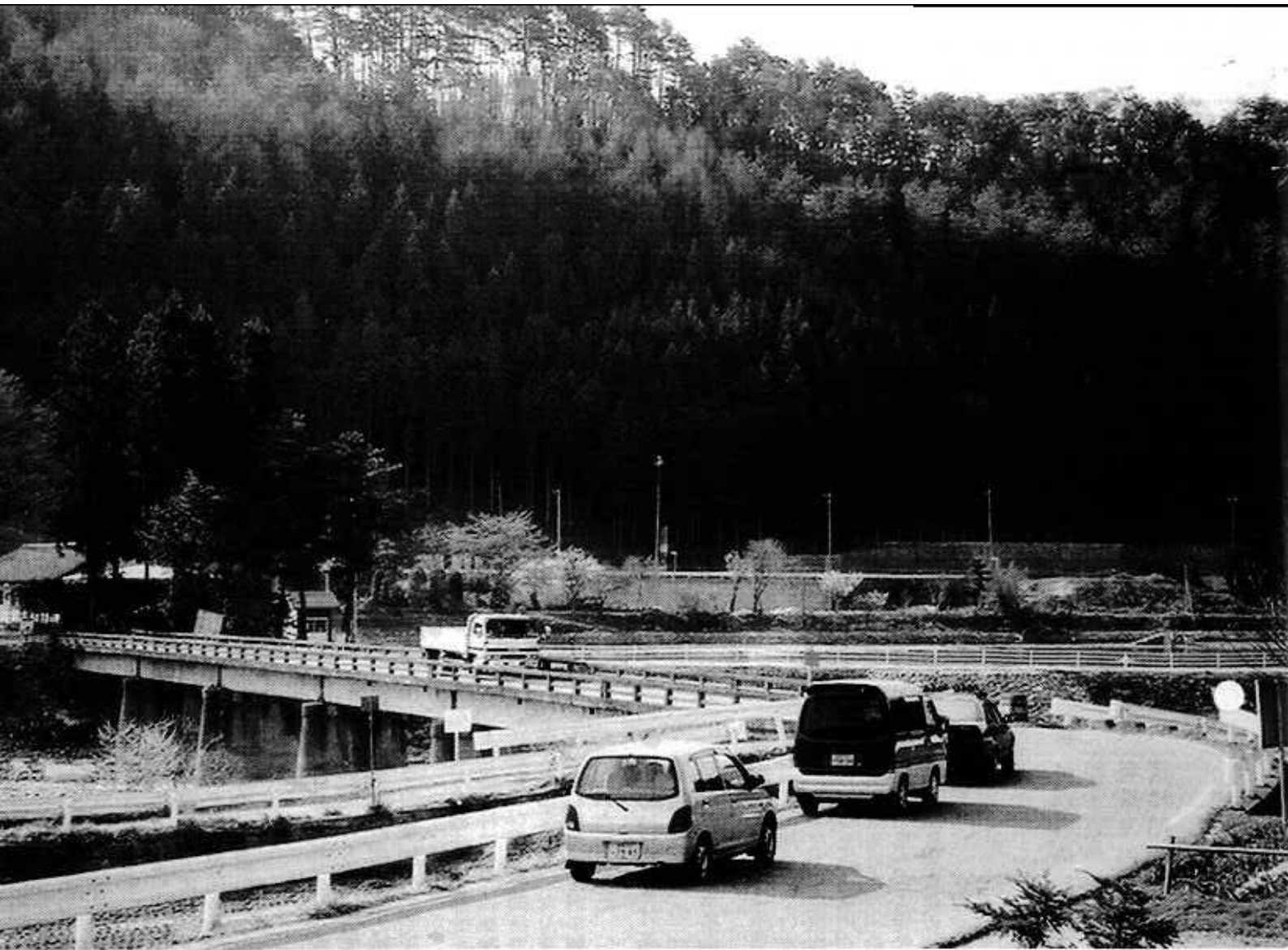
PHOTO 本年度から架け替え予定の摺淵橋
