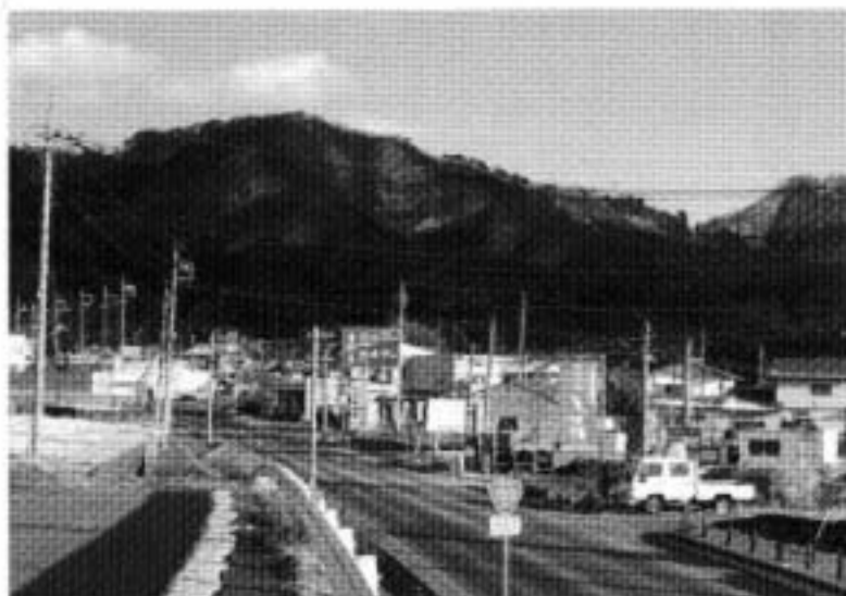
椎坂トンネルが予定される国道120号線 白沢町生枝付近
