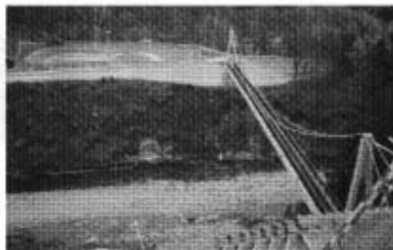
まちづくり交付金事業で整備中の吊り橋・他 (今年度完了予定)
