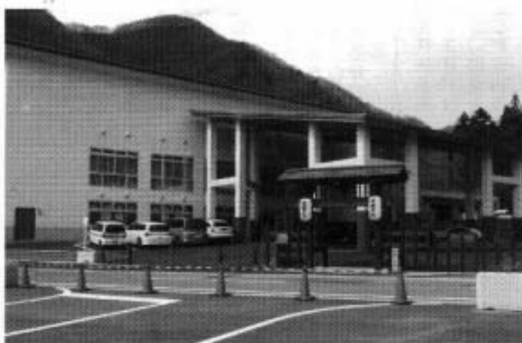
まちづくり交付金事業により完成した尾瀬ぶらり館
