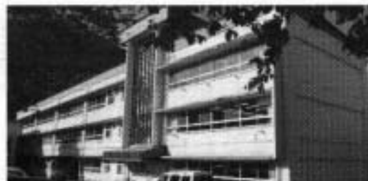
老朽化が進む中央公民館
