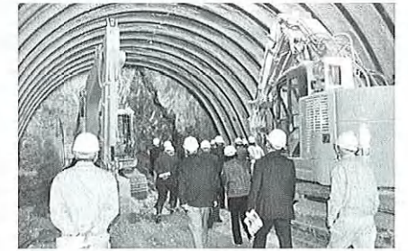
椎坂トンネルの見学 (日光市議も)
