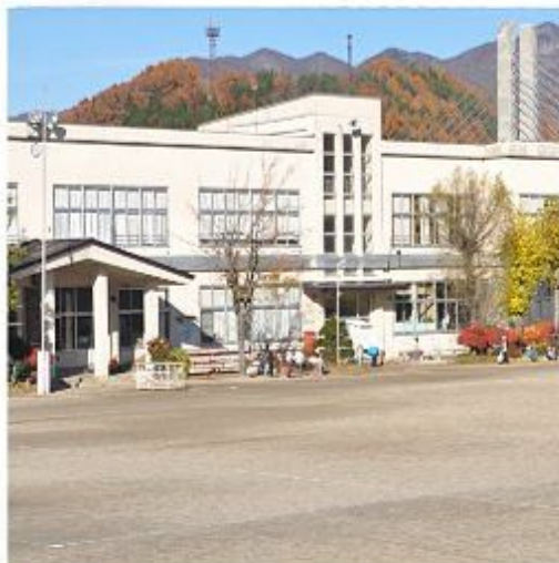
統合小学校が建設される片品小学校の今
