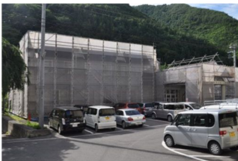
片品診療所屋根塗装工事
