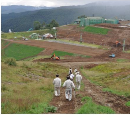
急ピッチで進む武尊牧場の クロカンコース
