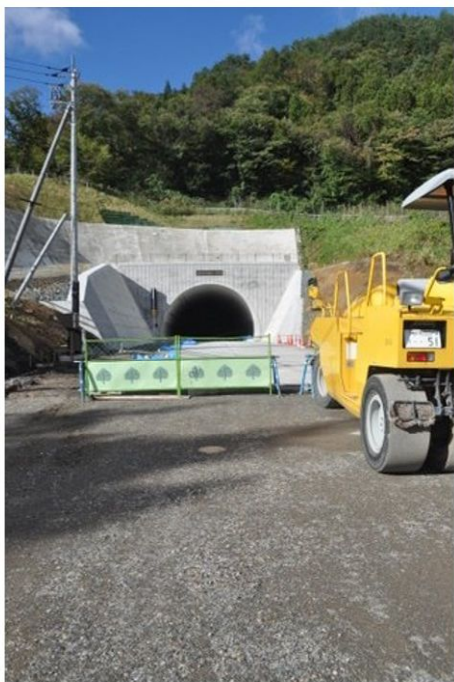
開通間近に撮影した椎坂トンネル(利根町の出入口)
