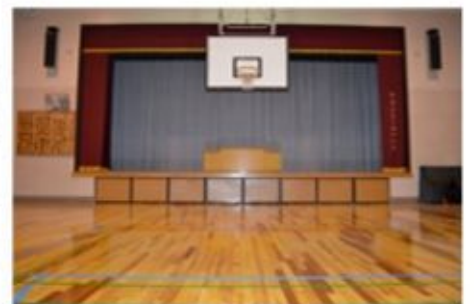
新装された片品北小学校体育館の床張り
