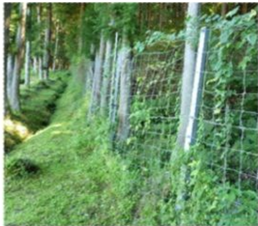
シカなどの鳥獣害侵入防止柵 (東小川地区) (農林建設課提供)
