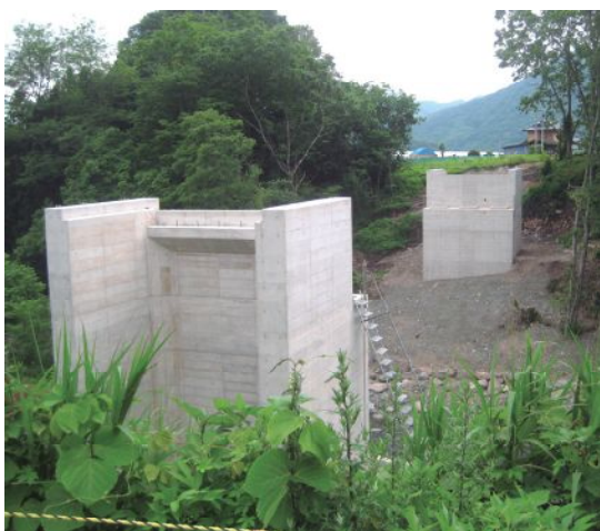
下部工が完成した塗川橋(幡谷)
