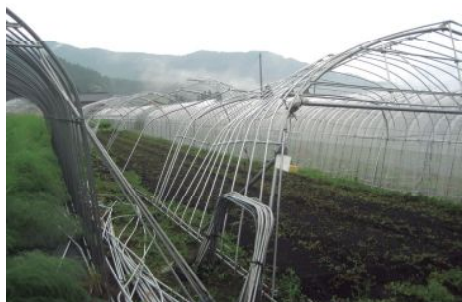
2月の雪害で被災したパイプハウス
