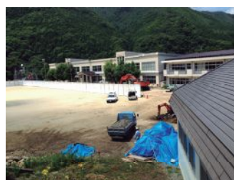
校舎解体が始まる旧片品小学校(鎌田)
