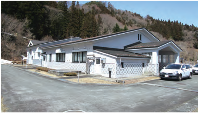
北部浄化センター
