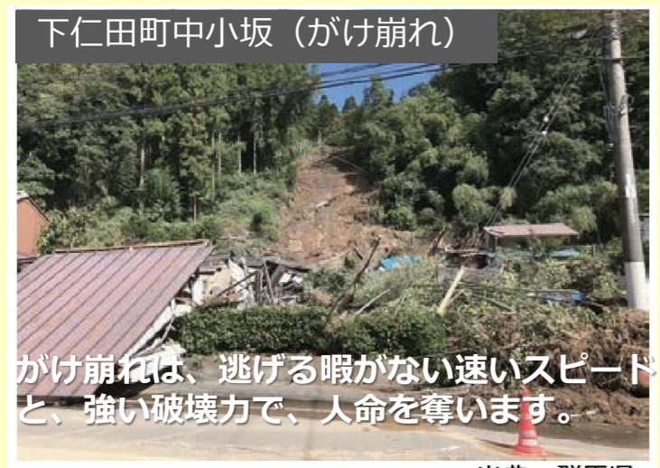
下仁田町中小坂（がけ崩れ） 出典：群馬県
