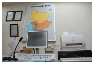
防災行政無線設置管理
