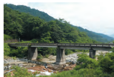
細工屋橋の修繕工事
